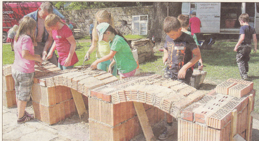
Fleißige Handwerker: Unter Anleitung lernten 30 Kinder beim Projekt Bauhütte an der Klosterkirche in Lippoldsberg verschiedene Handwerksberufe kennen. Dazu gehörte auch der Gewölbebau mit Maurermeister Martin Hensel (hinten links, halb verdeckt).
